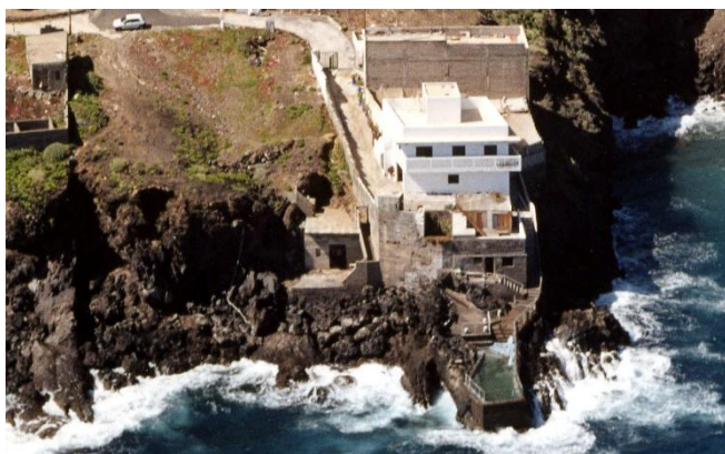
Ejemplo de construcciones no autorizadas en la costa
